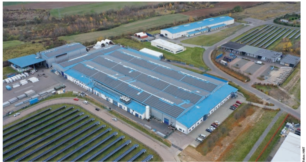
Die neue Photovoltaikanlage belegt bei HMT rund 10.000 Quadratmeter der gesamten Dachfläche
